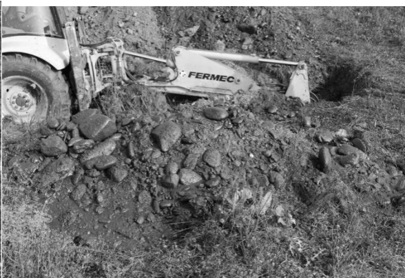
Fig. 3 Execuție șanț de investigare
